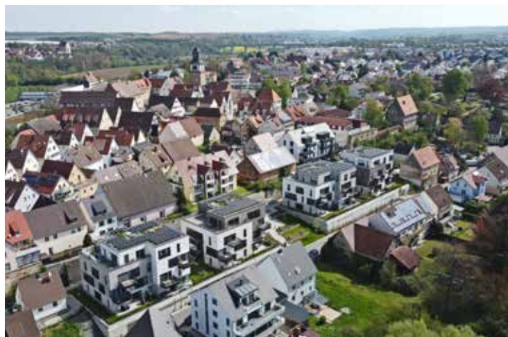
Attraktive Stadthäuser zwischen Mühlweg und historischer Stadtmauer (Fotograf: Markus Mahle)
